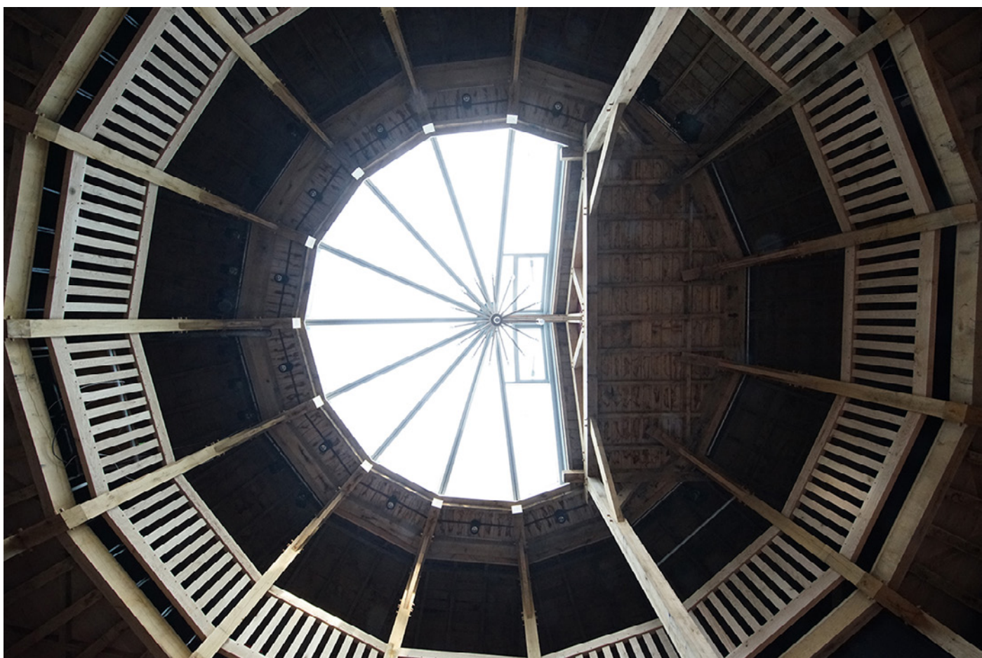
interieurbeeld zicht naar glazen kap
